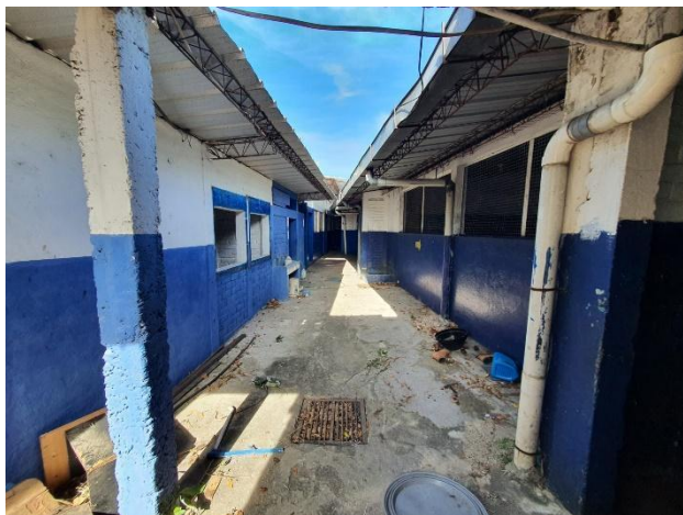
Corredor entre modulo B y A
