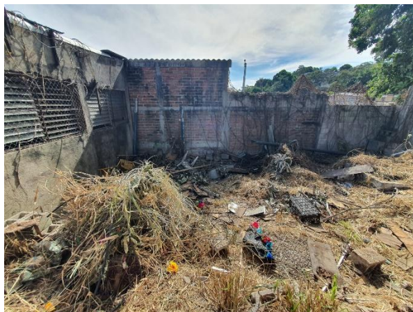
Predio baldío zona en mal estado parte posterior de modulo A
